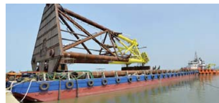
Chân đế giàn khai thác Thái Bình được hạ thủy thành công. Ảnh: PVC
