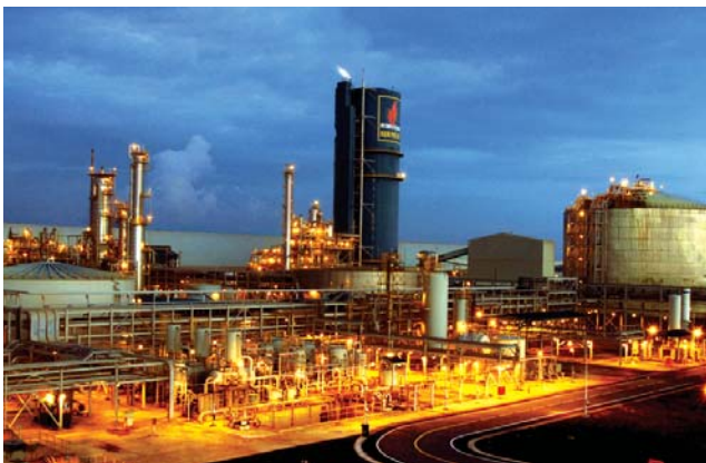
Nhà máy Đạm Phú Mỹ. Ảnh: PVFCCo
